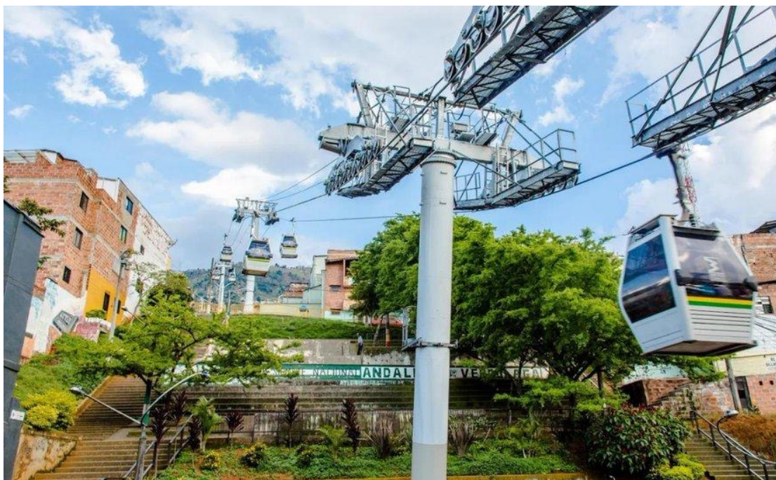
Línea K del Metrocable de Medellín. Fuente: Metro de Medellín, 2019.
